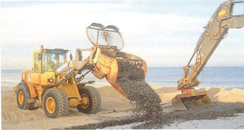
Im Rahmen des KLIMZUG-NORD Forschungsvorhabens wird ein neuartiges Deckwerk an der Westküste des Lister Ellenbogens gebaut. Durch die exponierte Lage des Deckwerkes eignet sich dieser Standort besonders für die praxisorientierte Klimafolgenforschung des Instituts für Wasserbau im Fachgebiet Küstenzonenmanagement der TU Hamburg-Harburg.
