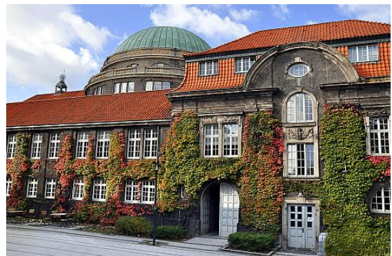
Universität Hamburg, Hauptgebäude
