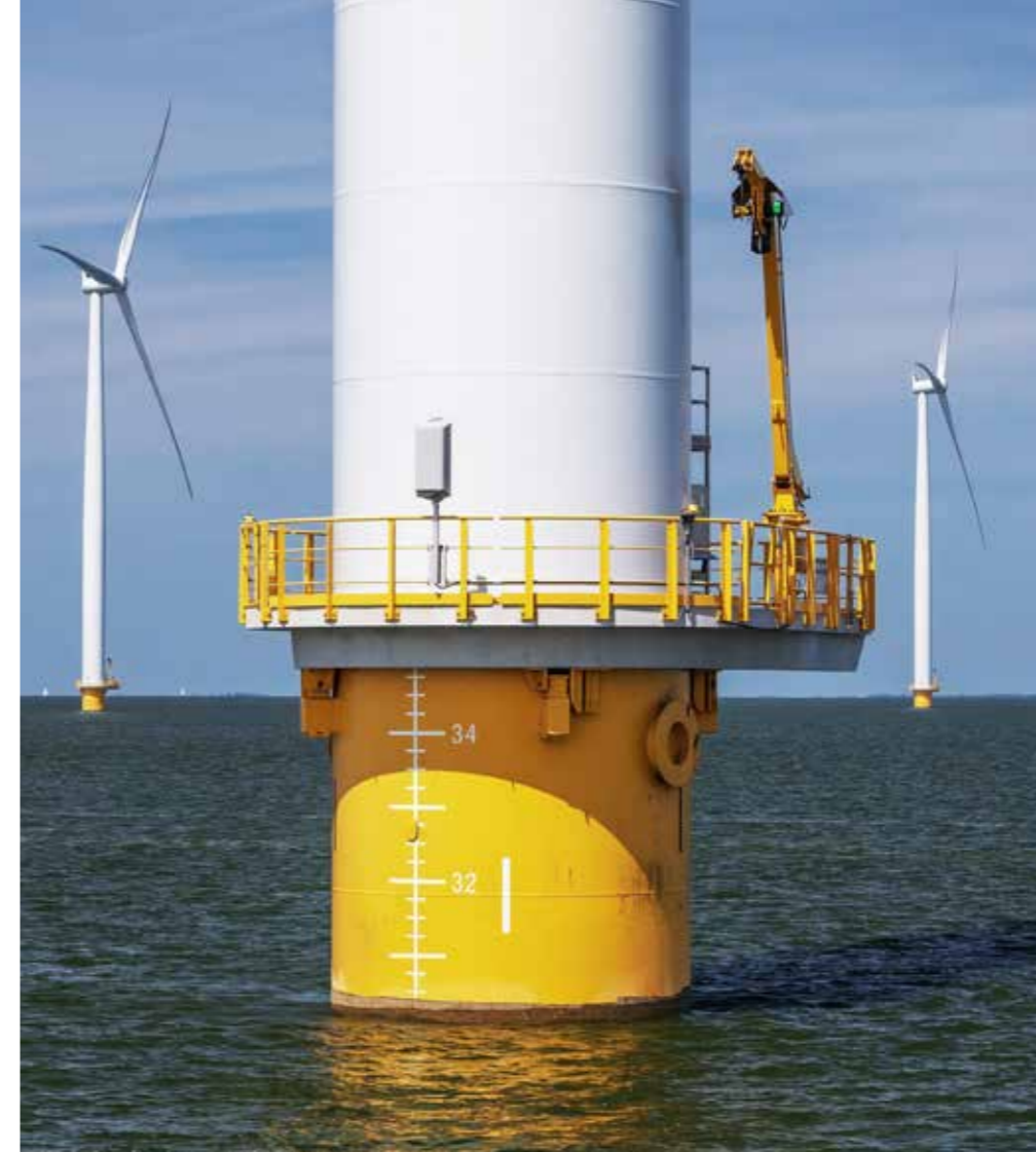
Monopile-Fundament eines Offshore-Windrads. Darauf wird an den Schweißnähten die Nanopflaster-Beschichtung für längere Haltbarkeit aufgetragen
