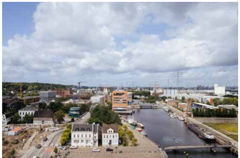
Der 9. Stock des ligeti zentrums im Harburger Binnenhafen bietet Labore und einen tollen Ausblick
