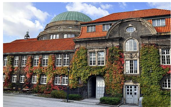
Universität Hamburg, Hauptgebäude
